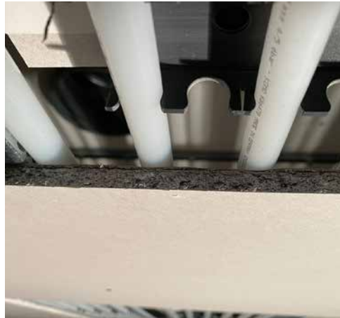
Gipskartonplatte als Untersicht
